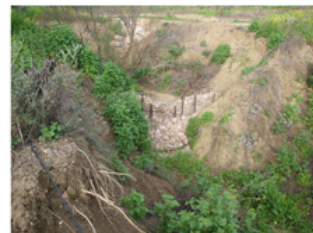
Dique de empalizada doble
